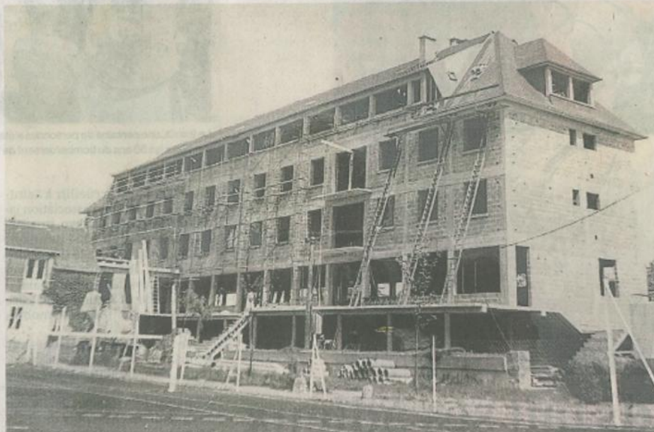
La construction du bâtiment Ty Gwenn, débutée en 1963, a permis d'héberger 80 jeunes. | PHOTO : OUEST-FRANCE
